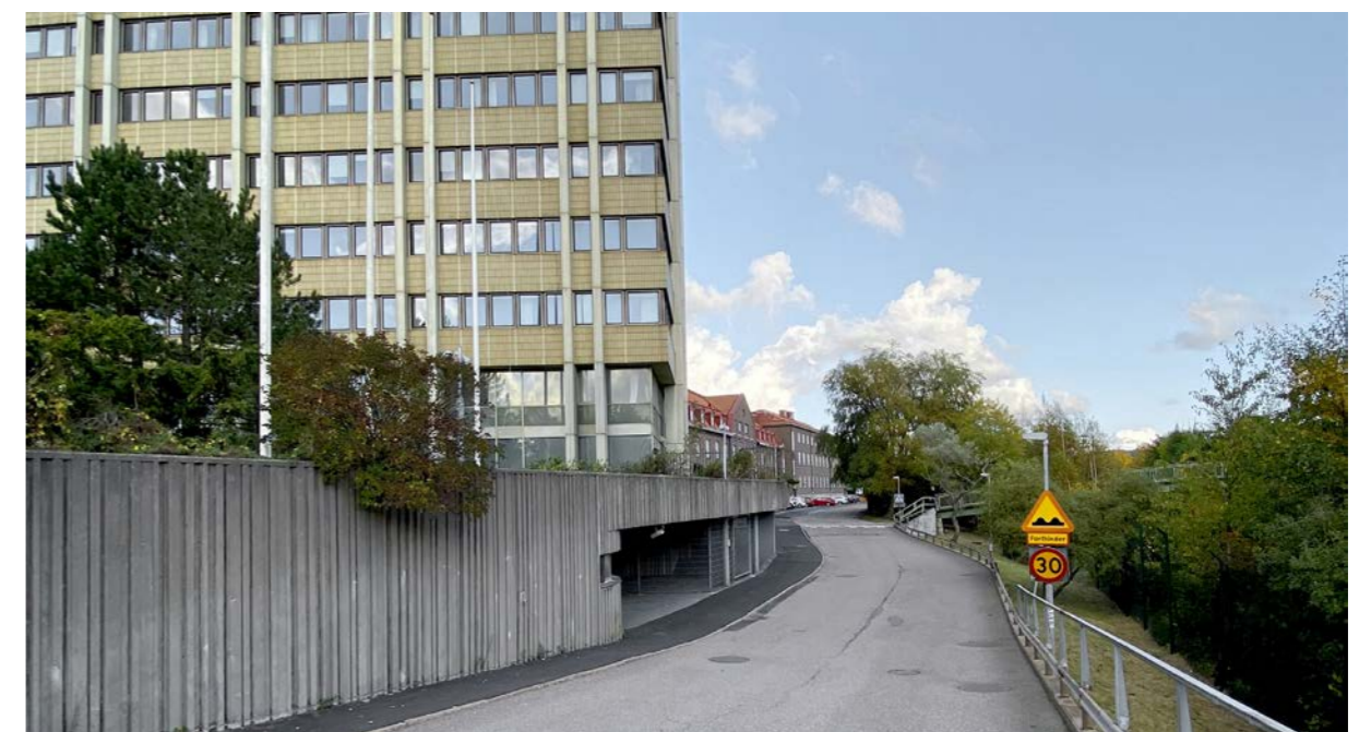
Infart till parkeringsgarage.
